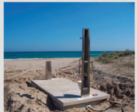
INSTALACIÓN EN LA PLAYA DE UN GRUPO P.M.R. CON POZOS DRENANTES
