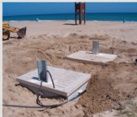
INSTALACIÓN EN LA PLAYA DE UN GRUPO P.M.R. CON POZOS DRENANTES
