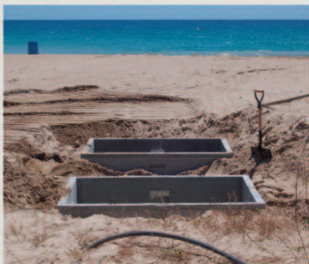
INSTALACIÓN EN LA PLAYA DE UN GRUPO P.M.R. CON POZOS DRENANTES
